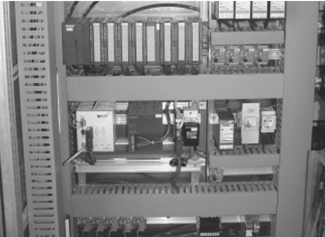
Über gut zugängliche Interfaces integriert FG-300 Profibus und Ethernet zu einem logischen Netzwerk.
