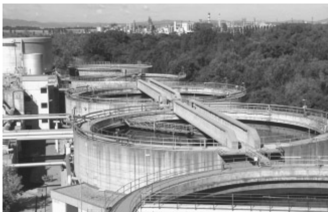
Kläranlage Schwechat Mannswörth.
